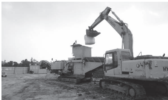
江蘇省でのプロジェクト(ヒ素汚染土壌の不溶化処理)現場。大きな白い袋が当社が製造した薬剤
