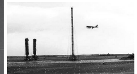
国による苅田工区の地盤改良
